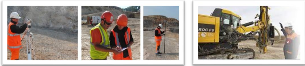
Préparation d'un forage et forage en carrière (source : site internet d'EPC Groupe)
