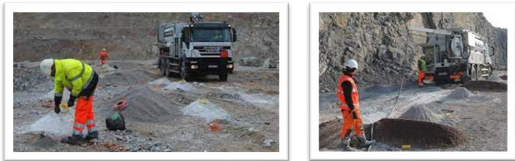
Opération de minage en carrière à l'aide d'une UMFc (source : site internet d'EPC France)
