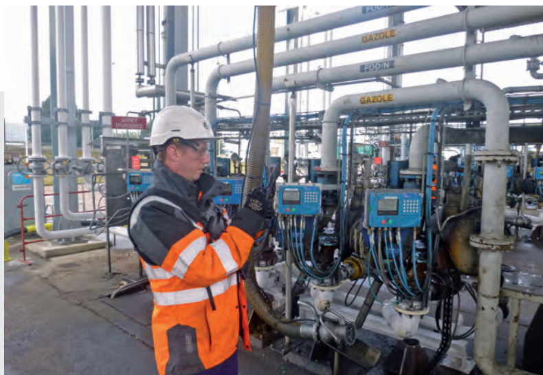
Intervention avec console portable sur un calculateur de dosage et quantité de chargement camion-citerne.
