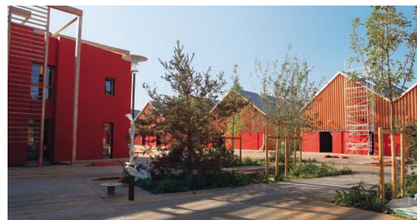
Aménagement d'un parc à vocation écologique, Parc nautique de Sèvres, Ile-de-Monsieur (92) Parc et bâtiments conçus et réalisés selon une démarche environnementale
