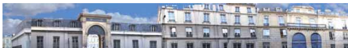
Immeuble situé au 47 à 51, rue Saint-Dominique Paris 7 ème
