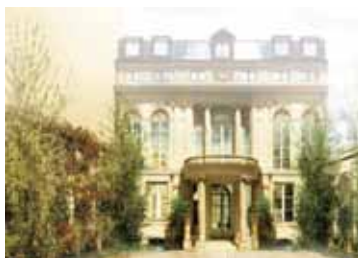
24, rue de l'Université Paris 7 ème (immeuble sur cour)
