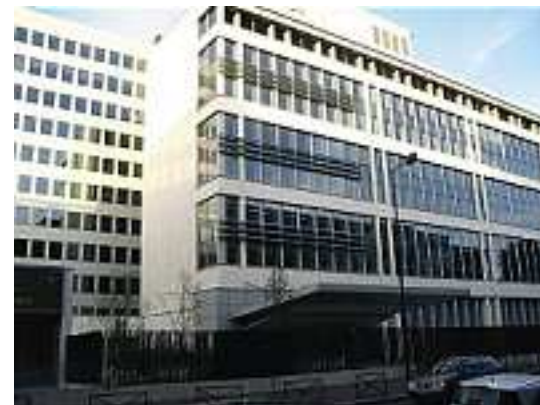
84, rue de Villiers, Levallois-Perret (92)
