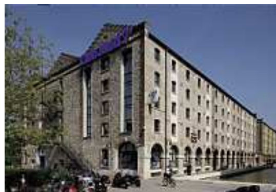
Bâtiment 025, parc du Pont-de-Flandre, Paris 19° (75)
