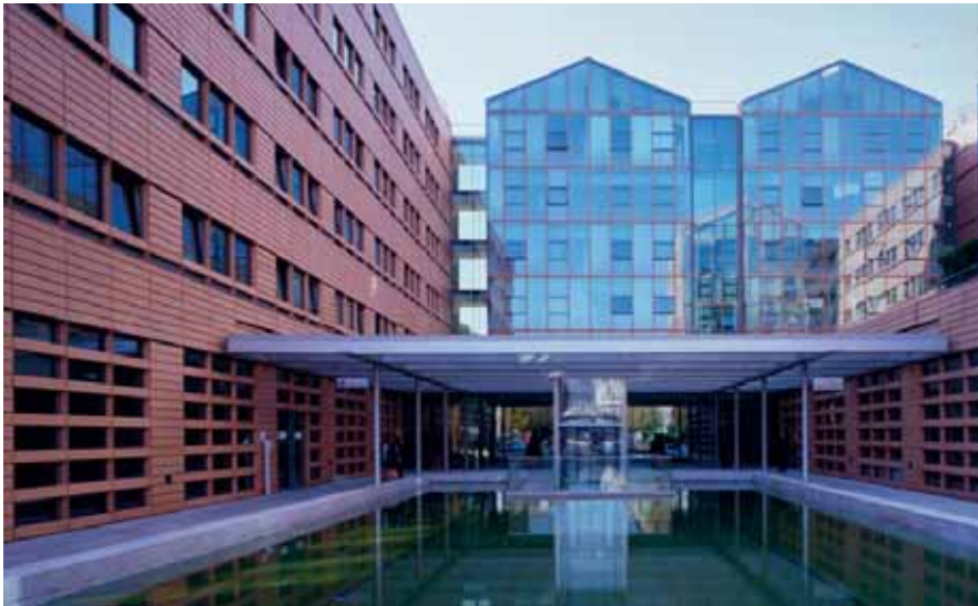
Bâtiment 264, Parc des Portes de Paris Aubervilliers (93)
