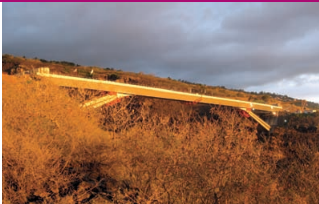
Viaduc de la Grande Ravine sur l'île de la Réunion.
