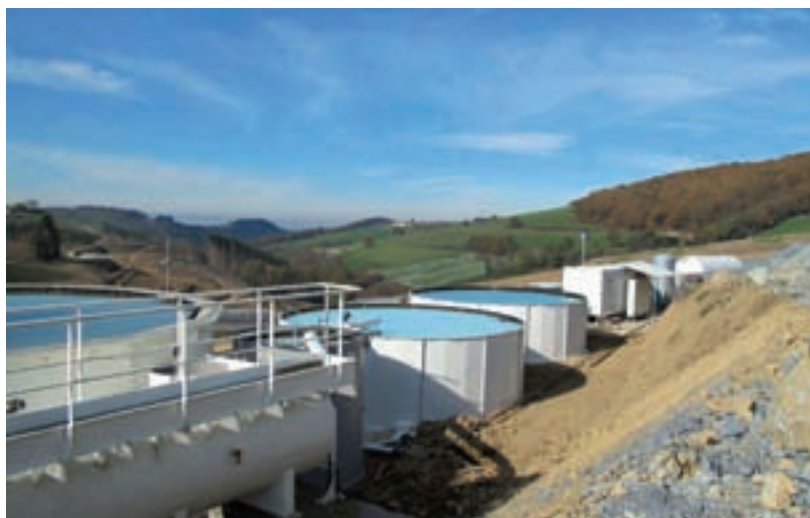
Tunnel de Violay, mise en eau des bassins et essai de la centrale Sotres de traitement des eaux.
