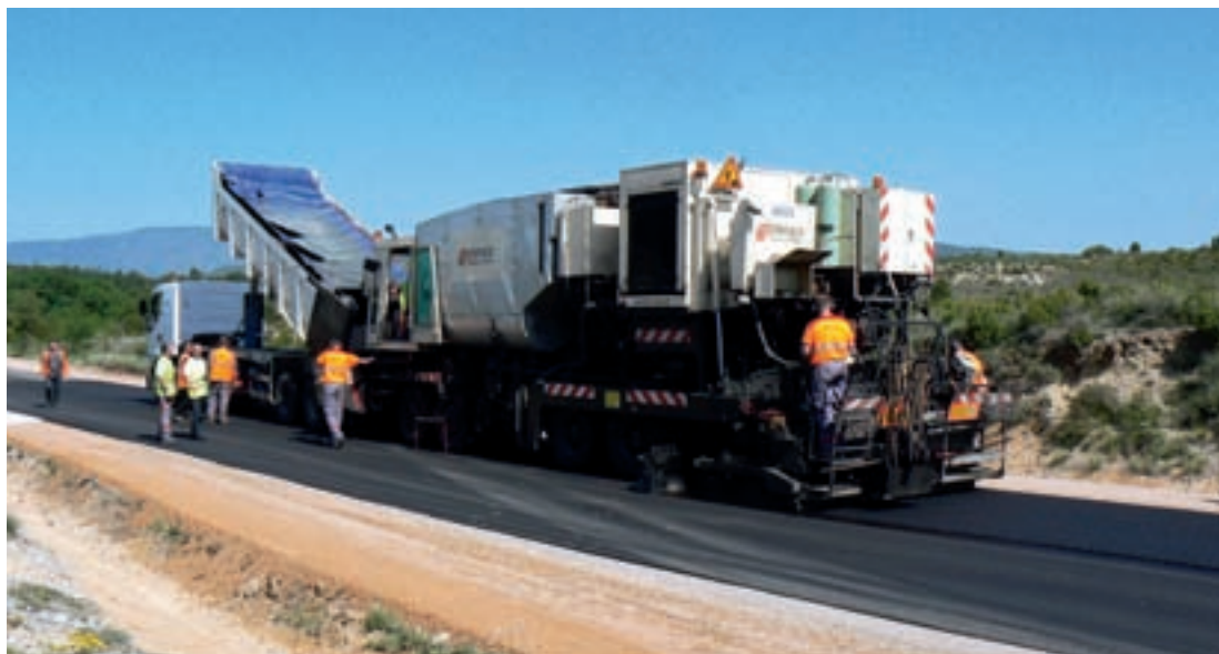
Le chantier STGV au pied du Pic Saint-Loup.
