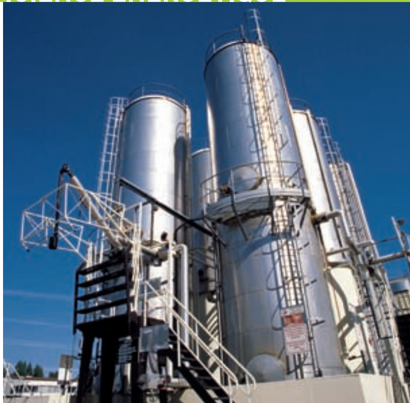
Usine de liants de Flers (Orne).
