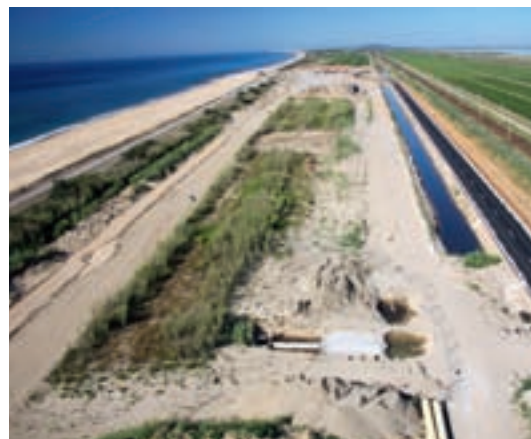
Les enrobés à basse températures (EBT®) d'Eiffage Travaux Publics sur le lido de Sète-Marseillan.
