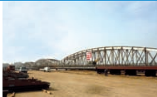
Le chantier du pont Faidherbe.
