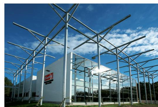
GINGER a conçu et construit clés en main le centre International de Recherche et de Développement sur les technologies aseptiques sur le site de Campbell Soup Company. Le bâtiment comprend une zone de process agro-alimentaire équipée de caniveaux inox, résine, production de froid. Le groupe a également procédé au raccordement aux réseaux de l'usine existante en sprinkler, eaux usées, vapeur, transformateur, chambre froide positive, chambre froide négative.
