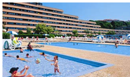
Via l'OPCI VIVAPIERRE (dont PAREF détient 27%) L'OPCI a réalisé d'importants travaux (19,2 M€) dans plusieurs villages en 2009 conformément au programme initial. Ici le village de vacances d'Anglet (64) acquis par l'OPCI en 2008
