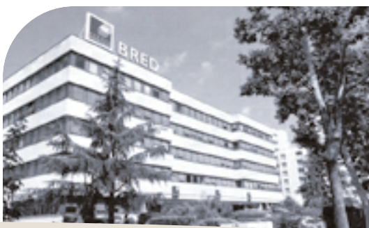
Siège de Créteil.
