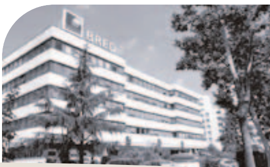
Siège de Créteil.
