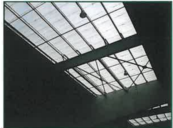
Charpente du nouvel entrepôt construit
