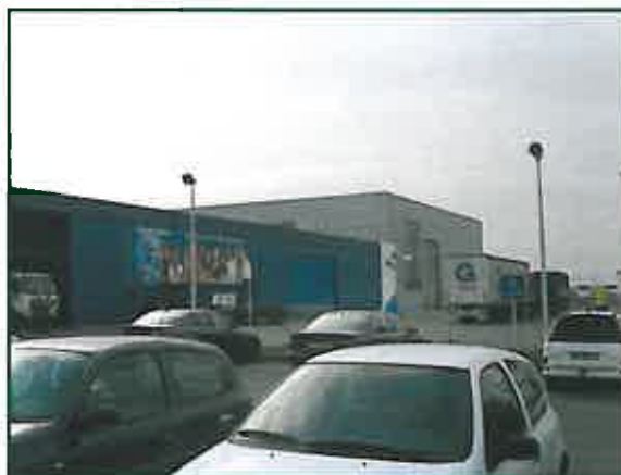
Façade et vue sur l'extension
