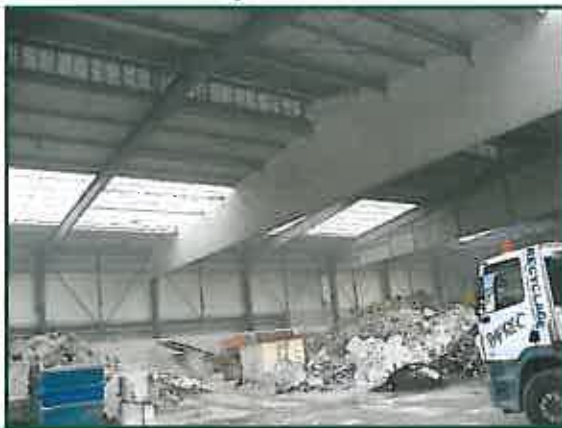
Nouvel entrepôt construit
