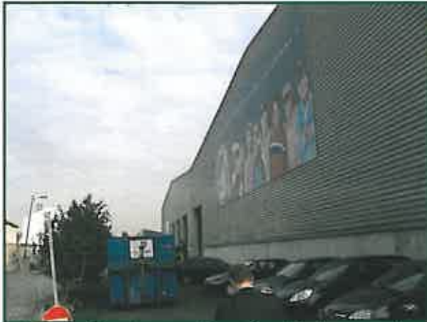
Route d'accès au site et façade du nouvel entrepôt construit
