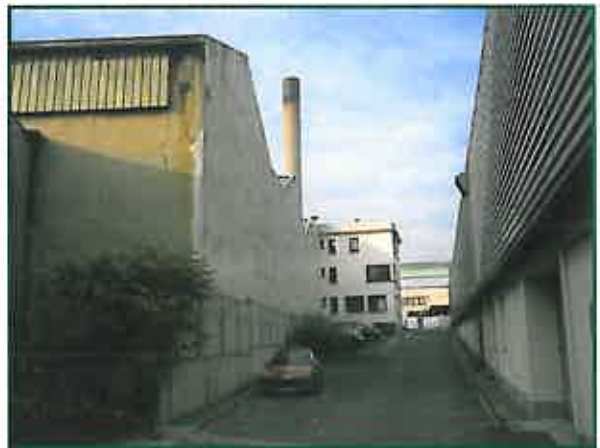
Voirie intérieure du site
