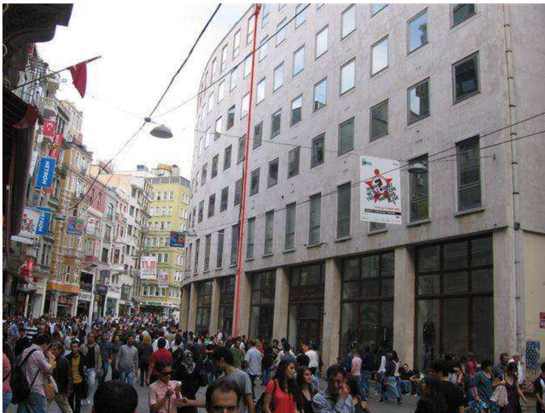
161 avenue Istiklal (partie droite du bâtiment)
