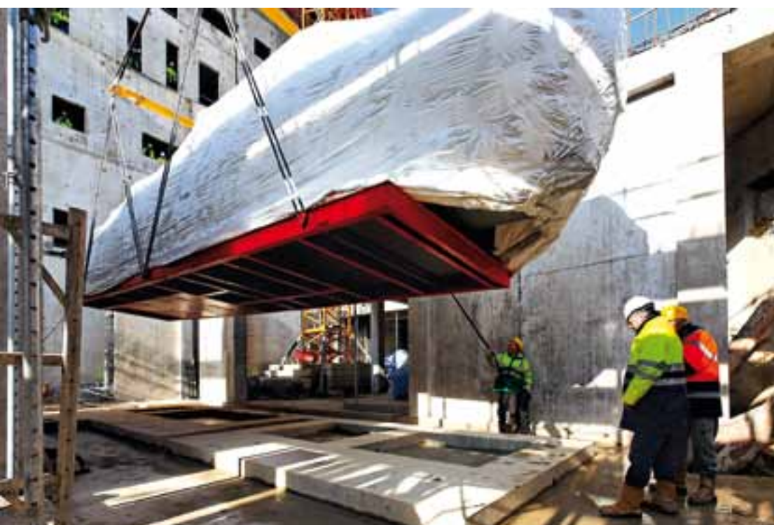
Grutage du turbo générateur du CHSF (Centre hospitalier Sud-Francilien).
