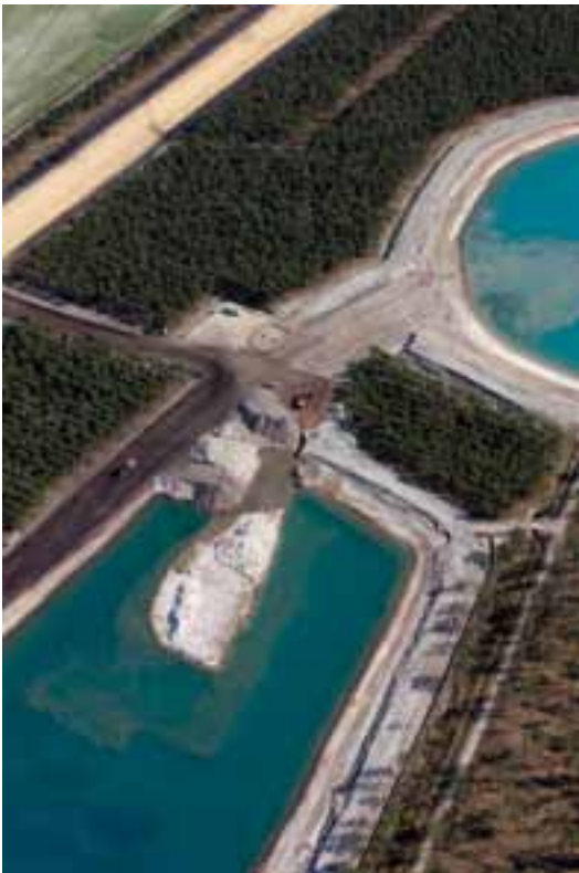
Bassins de décantation sur l'A65.
