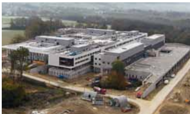
Le centre hospitalier intercommunal d'Annemasse Bonneville.
