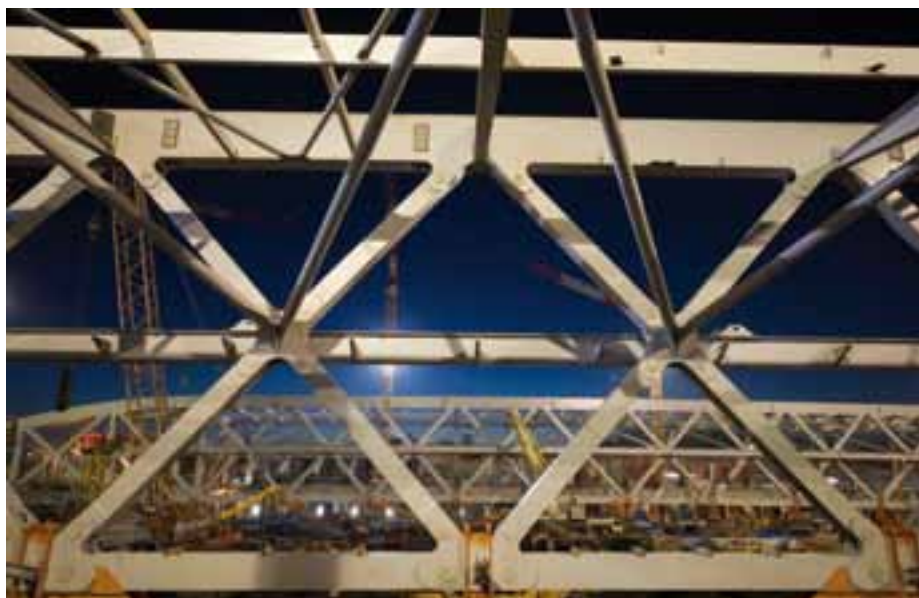
Les Mégapoutres (Eiffel) mises en œuvre au GSLM.
