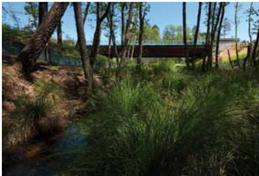
Viaduc du Ribarrouy (34 m d'ouverture).
