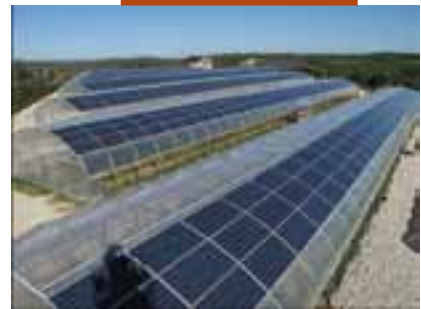
Les serres photovoltaïques de Solarneo St-Germain-du-Bel-Air (46).
