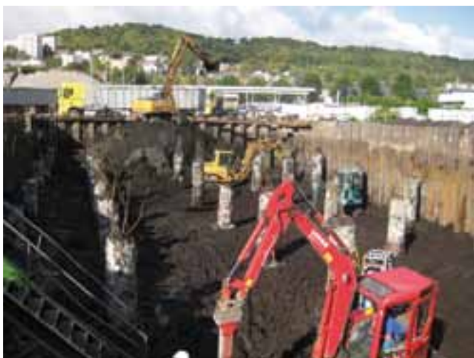
Boutté : évacuation de terres polluées - bassin de régulation du palais des sport de Rouen.
