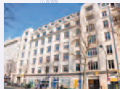
158/162, rue du Faubourg Saint-Martin Paris 10 e
