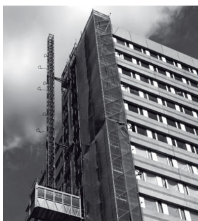
2009, façades mises à nu
