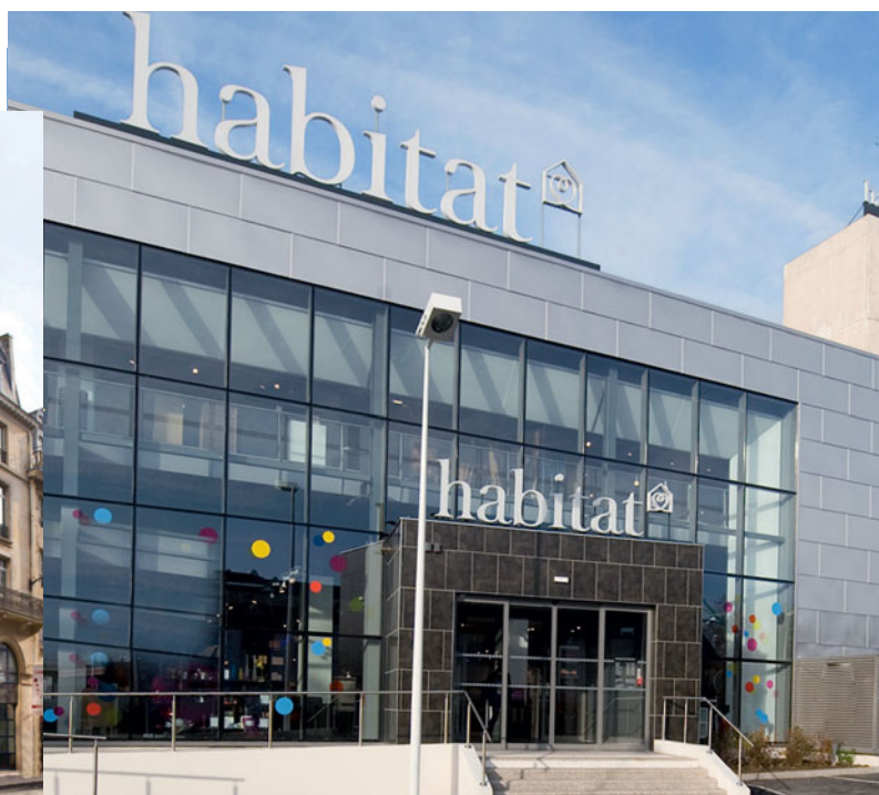
Carré Vélizy , ensemble mixte composé de deux immeubles de bureaux et de deux moyennes surfaces commerciales, Habitat et Office Dépôt, à Vélizy-Villacoublay en Île-de-France
