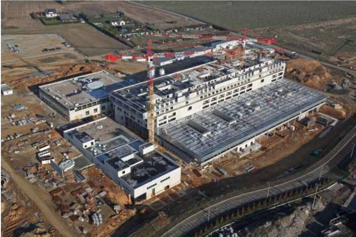
Chantier de l'Hôpital Privé de l'Estuaire, Le Havre (Seine-Maritime) - Janvier 2009
