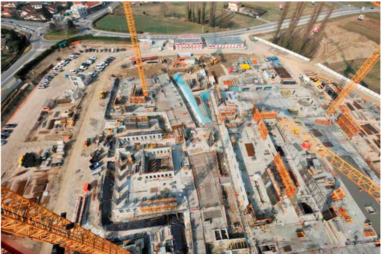
Hôpital Privé Nord Savoie, Annemasse (Hautes-Alpes)
