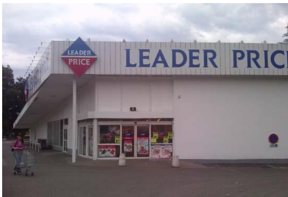
Rue Pierre Vincendon – La Tour du Pin (68)
