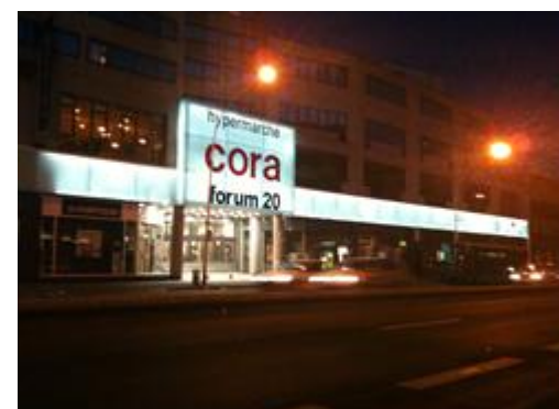
2010 : remplacement de la façade de Forum 20, Arcueil (94) après rénovation galerie en 2009
