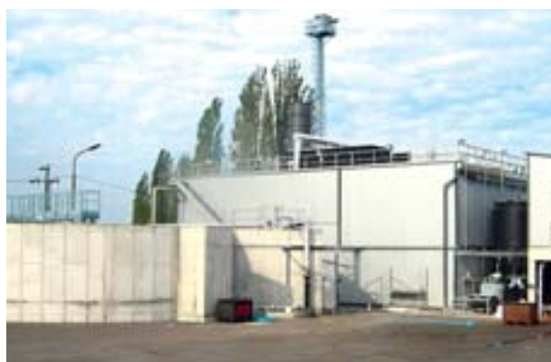
STATION D'ÉPURATION Usine de Békéscsaba en Hongrie.
