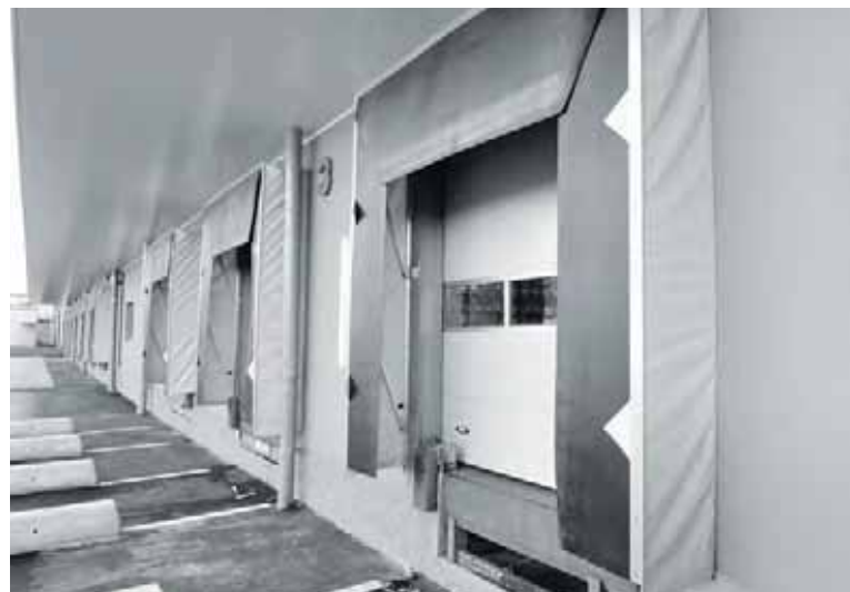
Isolation des portes des quais.
