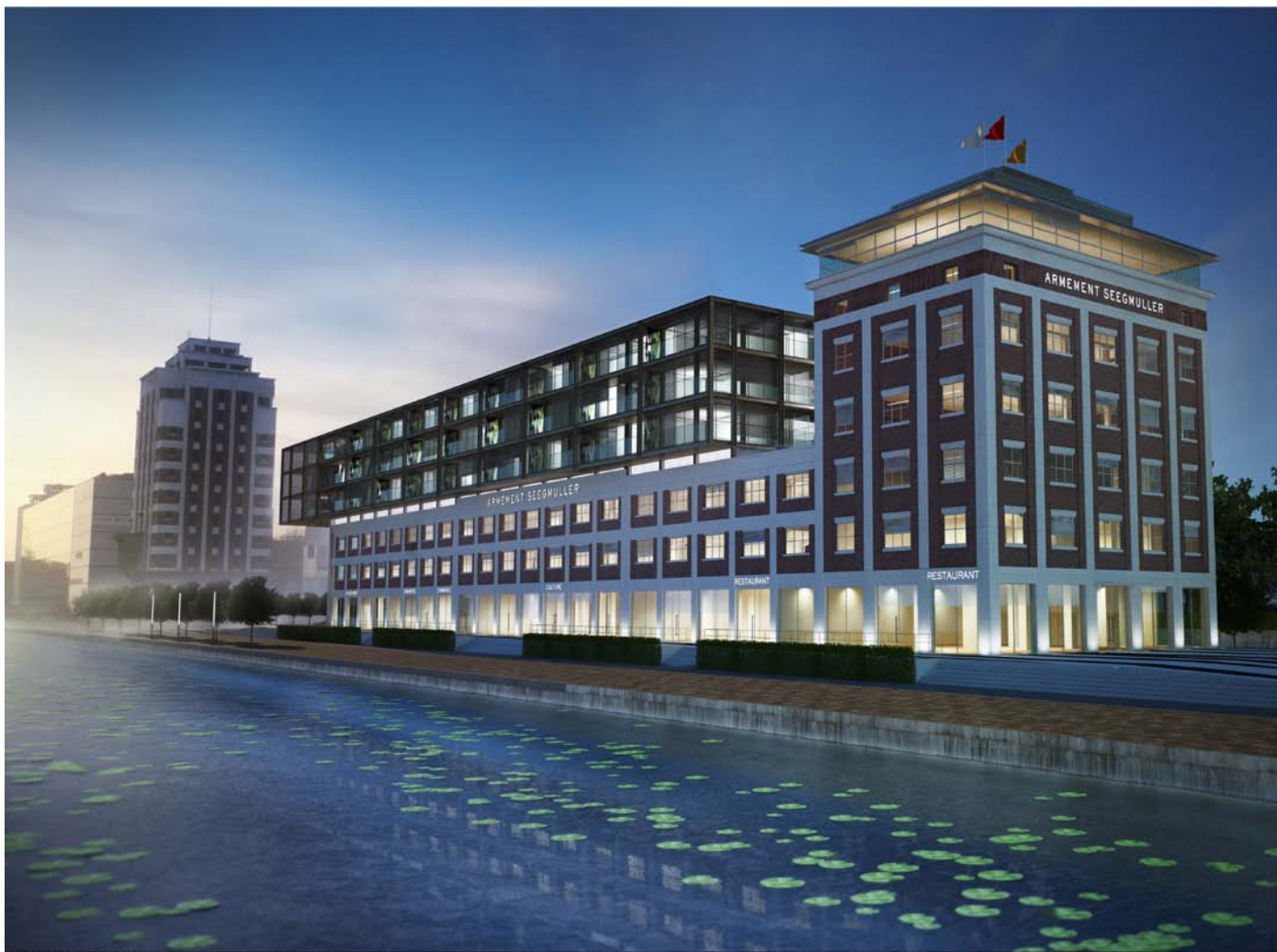
La Presqu'île André Malraux. Strasbourg (67). Icade : maître d'ouvrage. Architectes : Heintz et Kehr.
