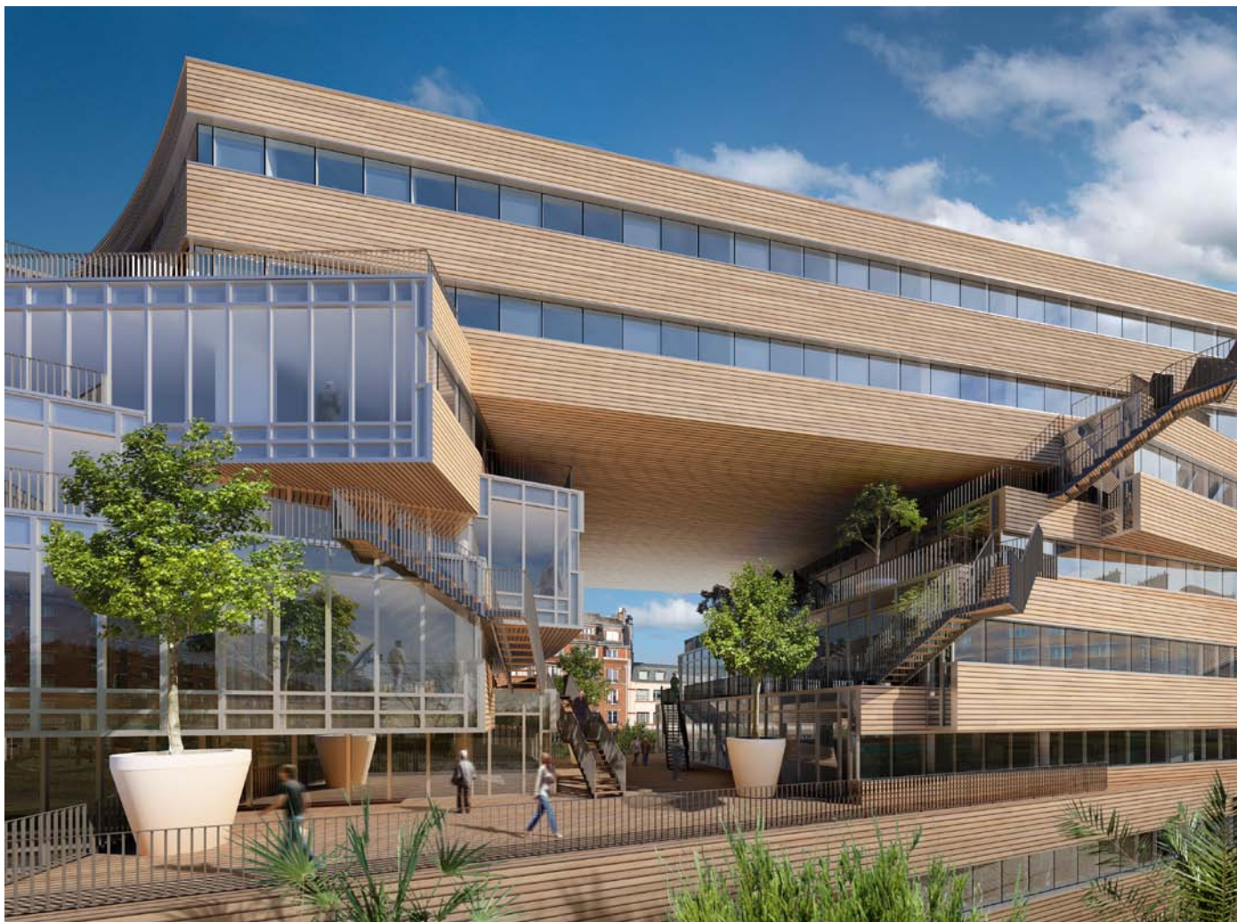
Pushed Slab. Paris (75). Icade : promoteur.
