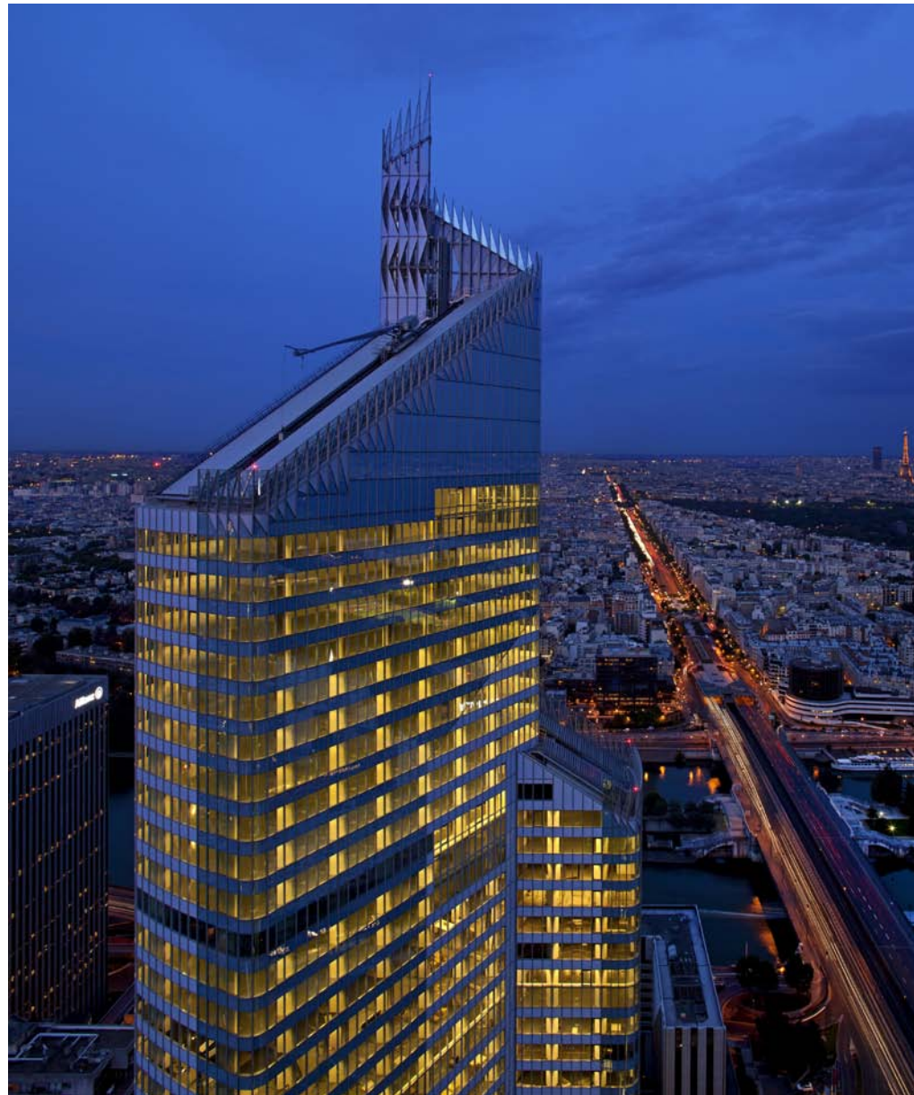
Tour First. La Défense (92). Icade : property manager . Architectes : Kohn Pedersen Fox associés, et Saubot et Rouit Associés.
