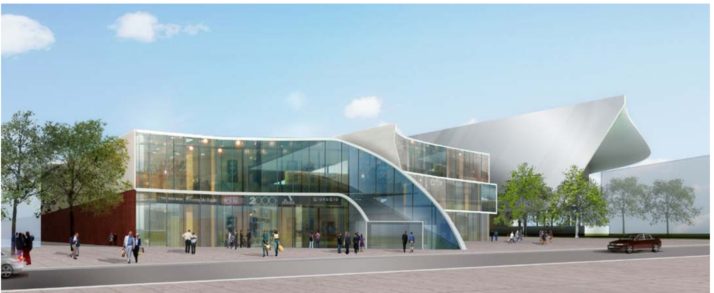
Centre commercial Bleu-Capelette. Marseille (13). Icade : promoteur et commercialisateur. Architectes : Arquitectonica - DGLA.
