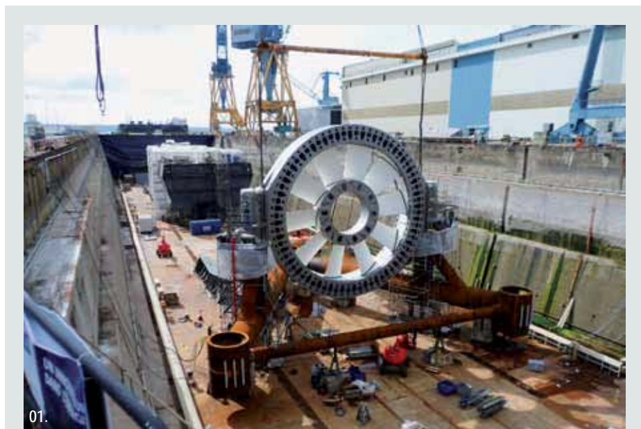
01. France – Transport d'une hydrolienne sur son socle métal réalisé par CMP Dunkerque.
