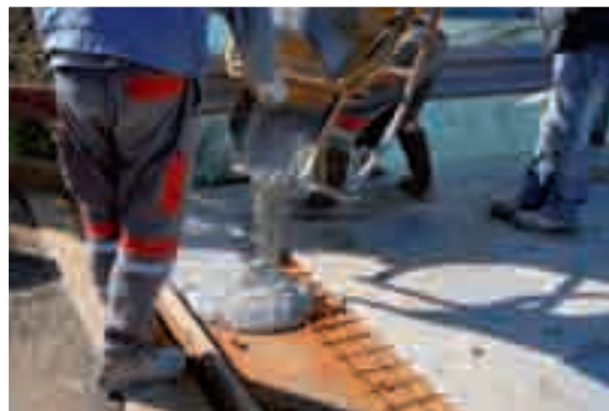
Mise en œuvre du procédé Orthodalle pour la rénovation du pont d'Illzach [68](Eiffage Travaux Publics).
