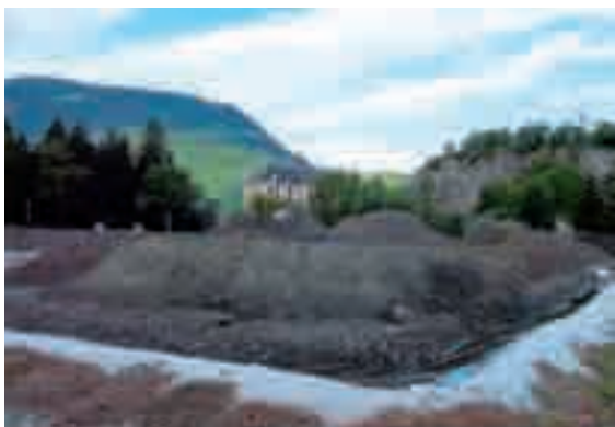
Vizille [38] : Excavation par passes successives suite à un diagnostic approfondi du site pour la réalisation d'une salle polyvalente pour la mairie de Vizille. Criblage des matériaux, puis traitement des terres polluées aux hydrocarbures sur plateforme étanche avec réalisation d'un bassin de récupération des eaux de pluie. Volume traité : environ 1 500 m 3 (Gauthey).
