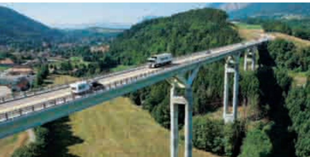
Viaduc de Monestier-de-Clermont sur l'A51.
