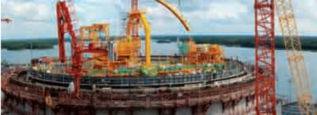
Le pont polaire OL3 en Finlande (Eiffage Construction Métallique).
