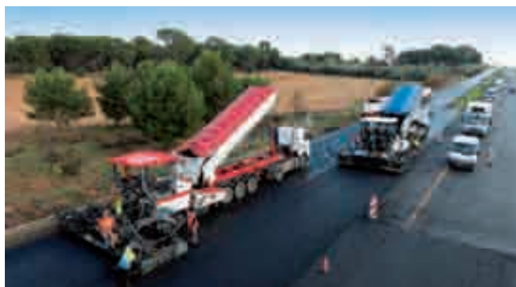
Pose du Nanophone® à Vias (34) [Eiffage Travaux Publics].
