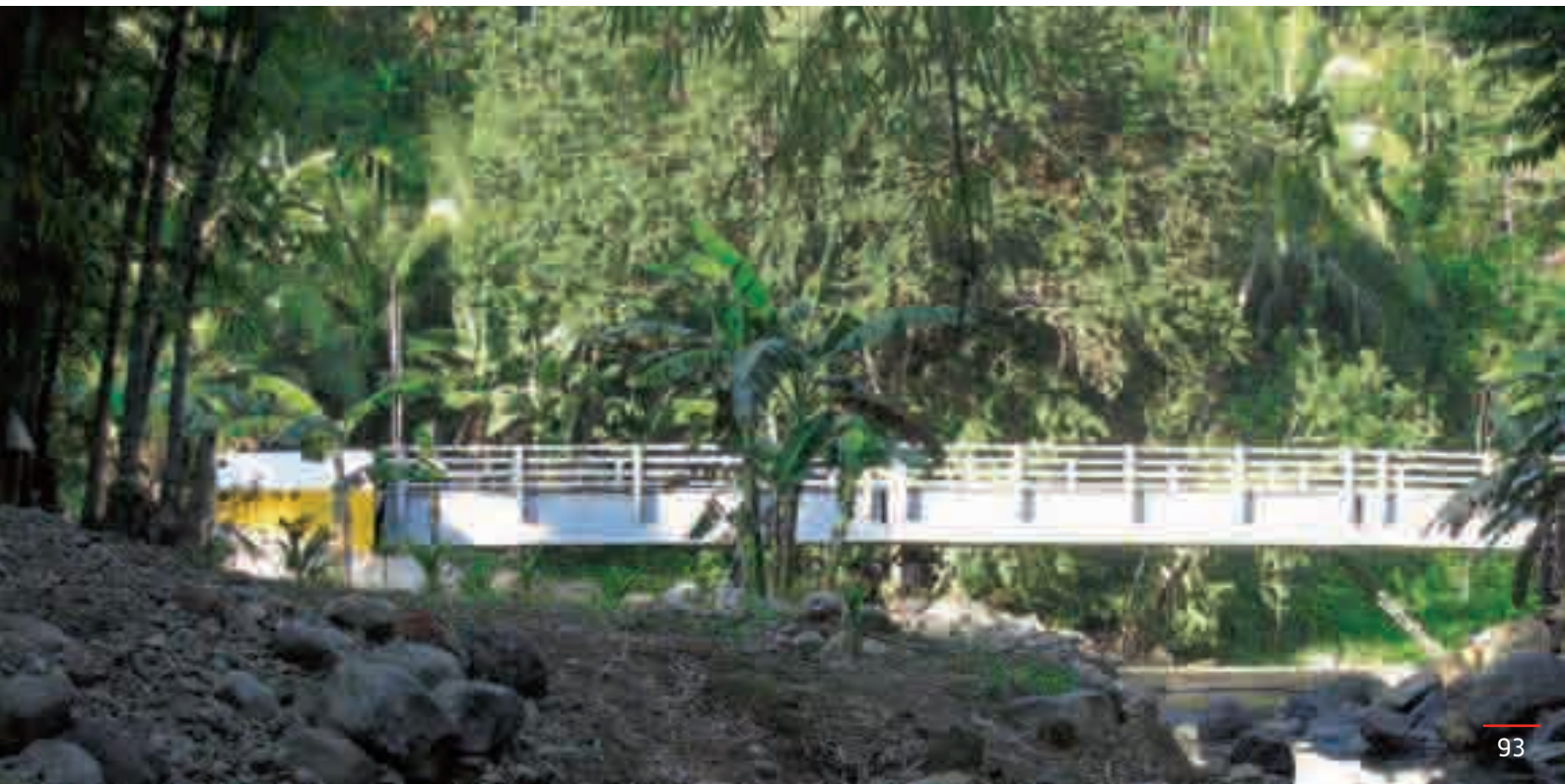
Un pont Unibridge® aux Philippines (Branche Métal).
