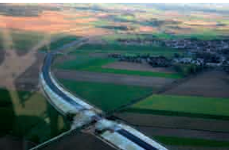
Le chantier du contournement de Cantin [Eiffage Travaux Publics].
