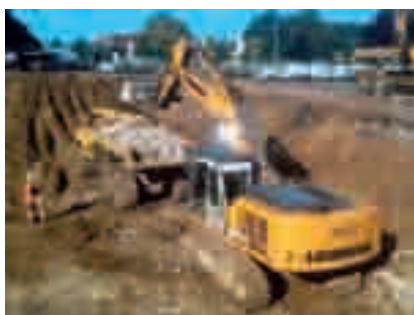
Creusement du bassin tampon des eaux pluviales sur le site de Verquin (Eiffage Energie).
