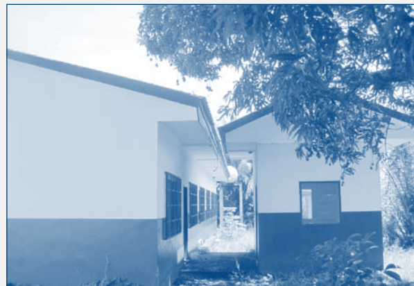
Dispensaire de Nombedouma rénové et équipé. Lac Onangué
