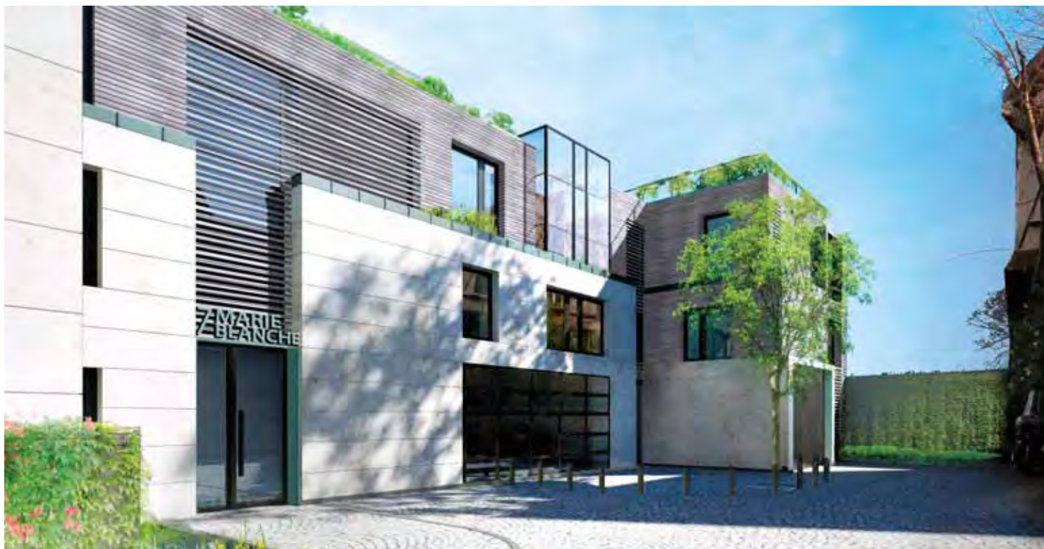
IMPASSE MARIE-BLANCHE À MONTMARTRE (PARIS, 18 E ARRONDISSEMENT). L'ensemble de la superstructure et des façades de cette opération certifiée NF Logement-démarche HQE® a été conçu en bois, matériau 100 % naturel bénéficiant de très bonnes propriétés thermiques et acoustiques.
