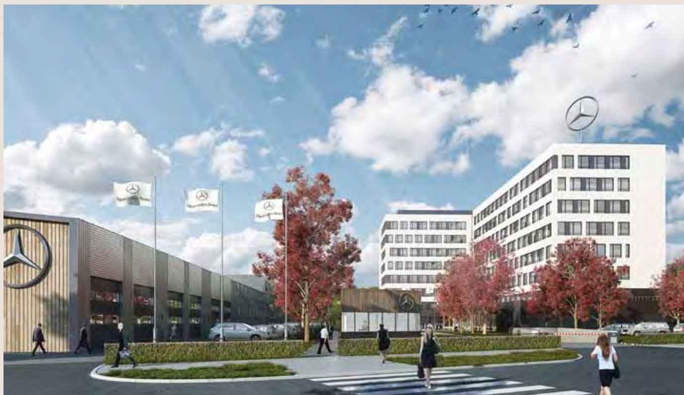
LE FUTUR SIÈGE DE MERCEDES-BENZ FRANCE, en partenariat avec CFC Développement, un campus sur deux hectares, à Montigny-Le-Bretonneux (Yvelines).
