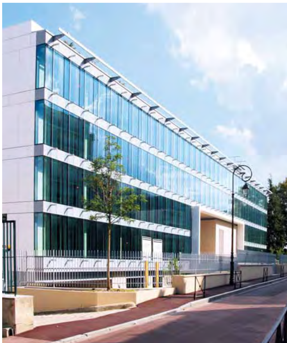
RESTRUCTURATION DU CLUBHOUSE, l'ancien siège social d'Interpol à Saint-Cloud (Hauts-de-Seine).
