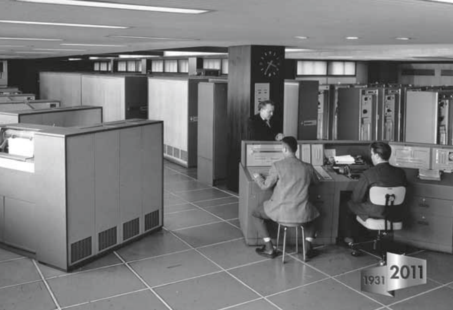
Conçu dans les laboratoires Bull à partir de 1957, le Gamma 60 est le premier ordinateur multitâche et multiprocesseur au monde.
