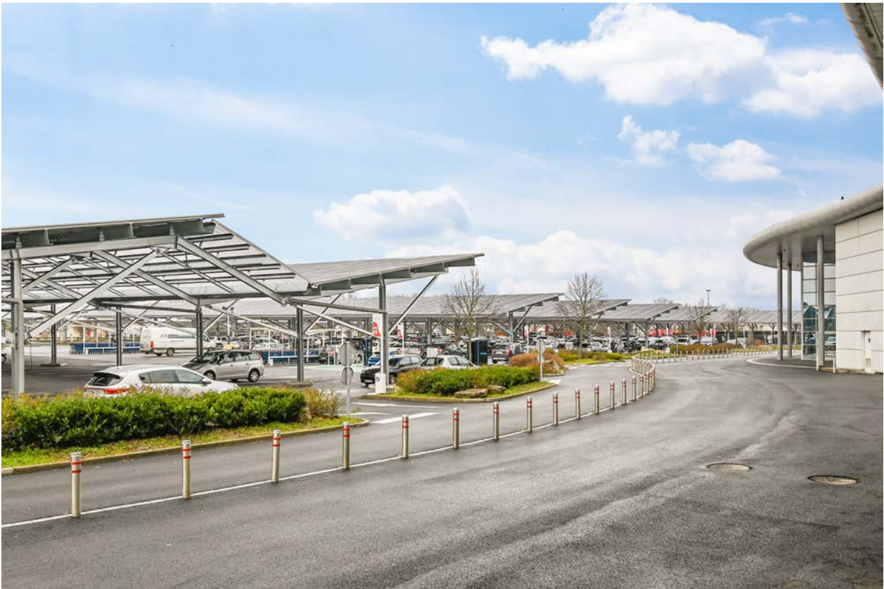
Shop'in Witty (Wittenheim) – Finalisation de l'installation des ombrières en 2022
