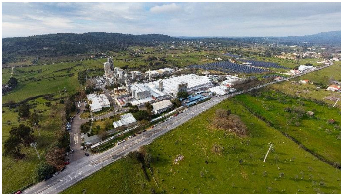
Figure 3 : vue aérienne du site industriel de Selenis à Portalegre au Portugal
